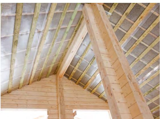
Рис. 63. Пароизоляционный слой
