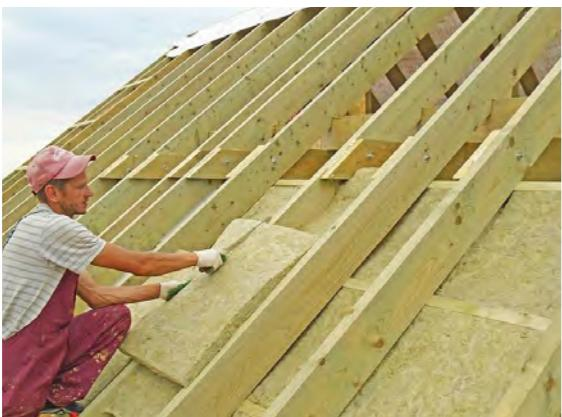
Рис. 62. Теплоизоляционный слой
