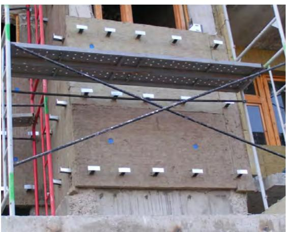
Рис. 118. Установка утеплителя
