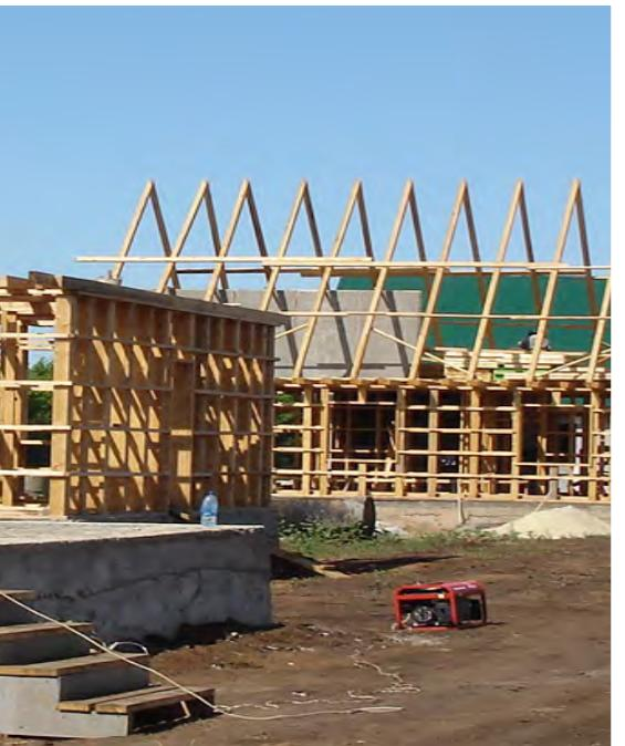
Эта конструкция так же обеспечивает хорошую теплозащиту, сейсмостойкость и долговечность. Она применяется при возведении наружных и внутренних стен, а также полов и перекрытий малоэтажных зданий и сооружений по каркасной технологии.
