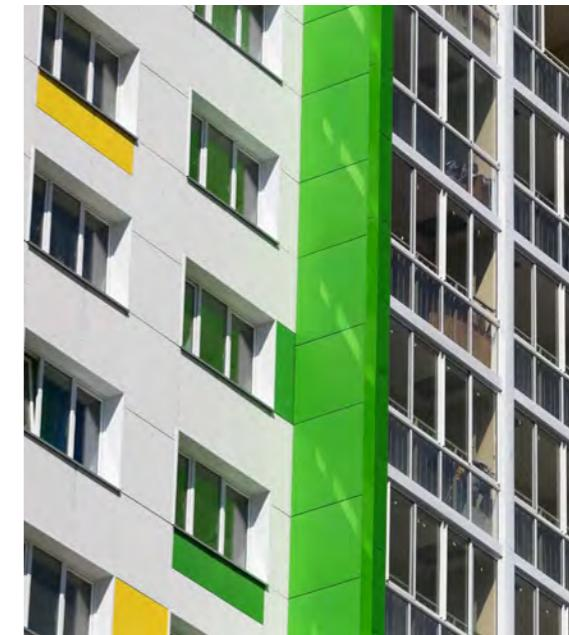
Рис. 16. Навесной вентилируемый фасад
