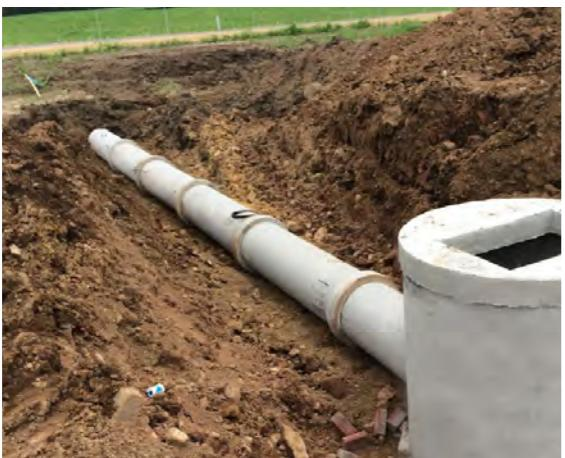
Рис. 23. Трубопровод из ХЦ труб
