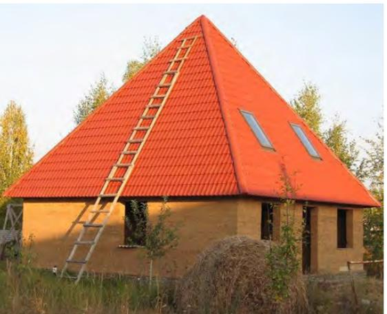
Рис. 73. Шатровая крыша
