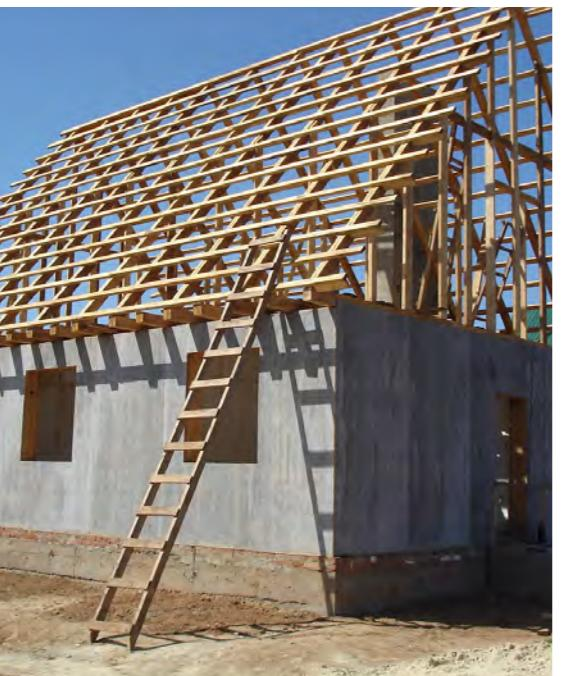
Рис. 128. Стены из ХЦ на деревянном каркасе
