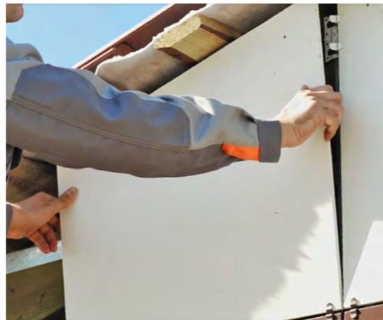
Рис. 42. Монтаж стеновых панелей
