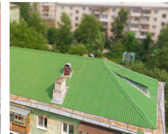
Рис. 70-71. Четырехскатные крыши многоквартирных домов
