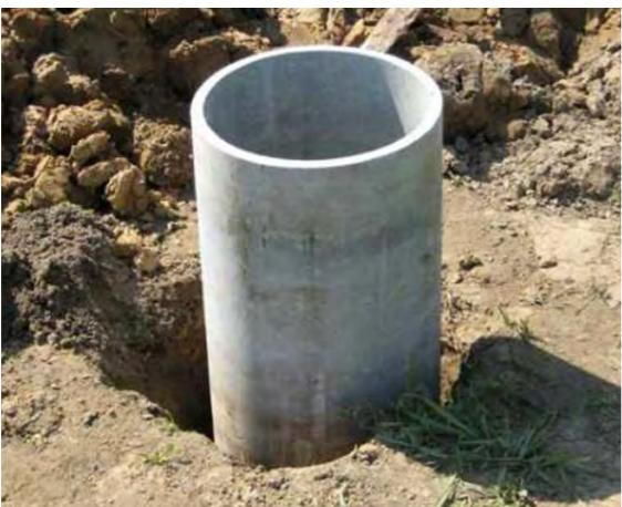
Рис. 48. Скважина из ХЦ трубы
