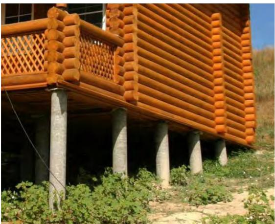
Рис. 50. Опоры столбчатого фундамента
