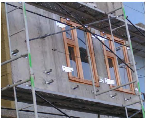
Рис. 117. Кронштейны несущего каркаса
